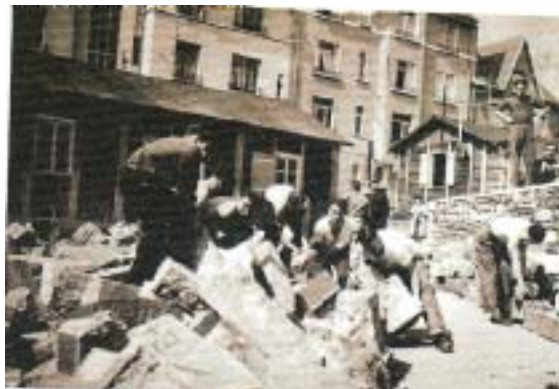
Travaux d'électrification du terrain de basket par les adhérents
