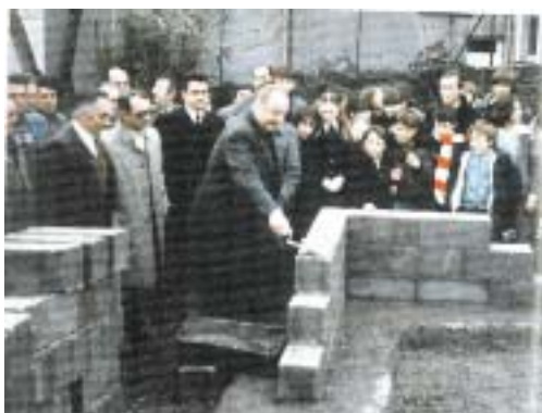
Pose de la première pierre de la salle polyvalente par F. Le Blé
